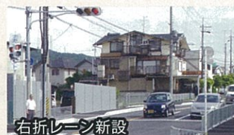
右折レーン新設
